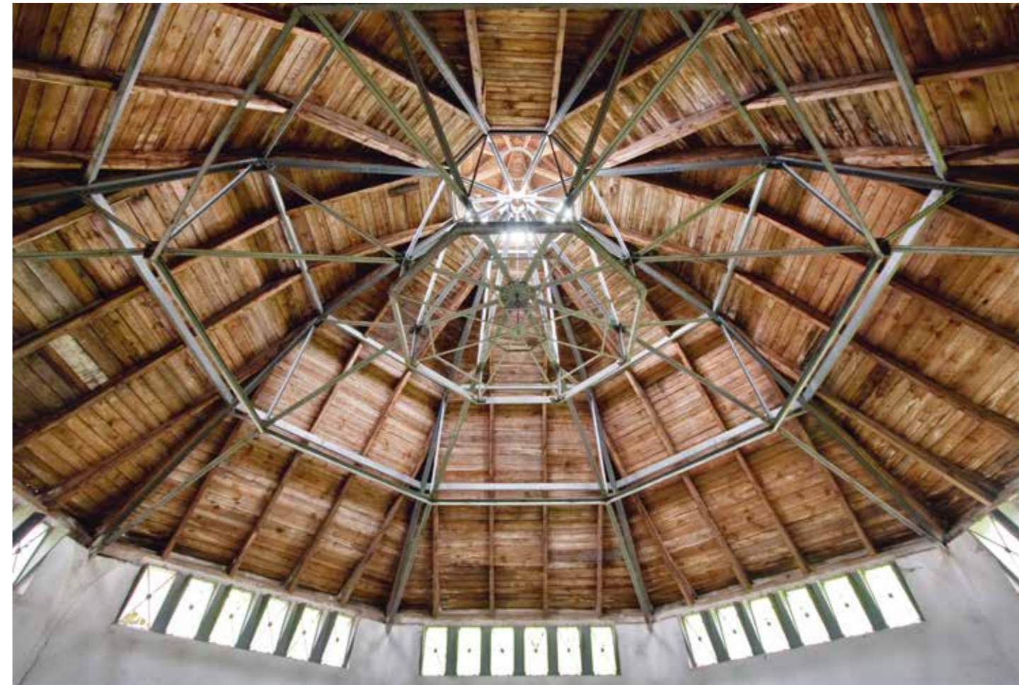
Unter dem Oktogon-Dach des früheren Pferdestalls parken heute Schlitten und Kutschen. Die Räume vermietet Jens Jacobi für Ausstellungen, Feste oder Aufführungen.
